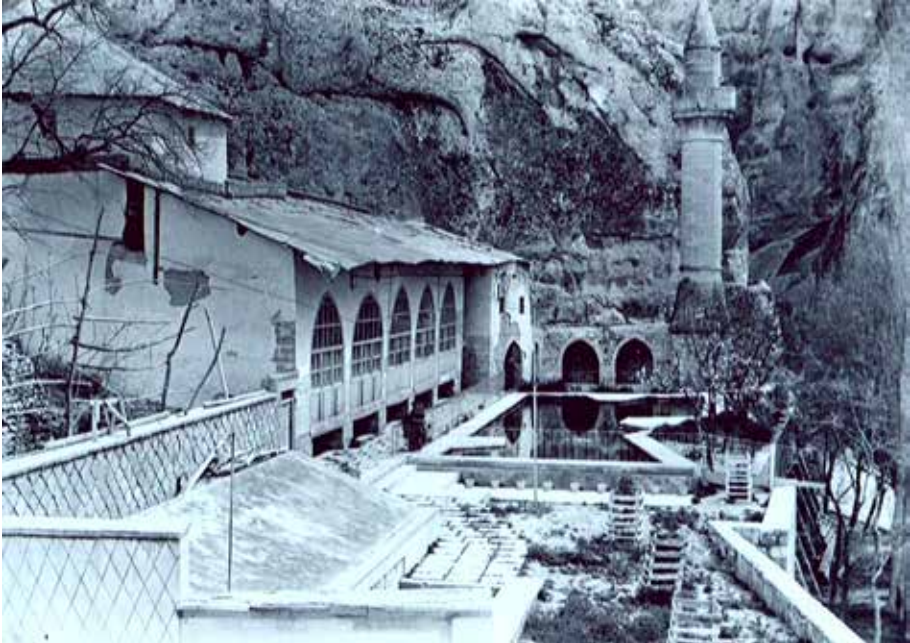
• Şeyh Hâmid-i Velî/Somuncu Baba Camii ve Türbesi'nin Restorasyondan Önceki Durumu
